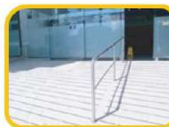
Rampa de acceso
