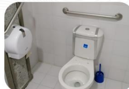
Baño con barandas soporte
