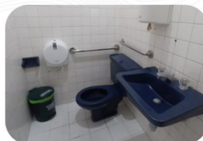
Baño con barandas soporte
