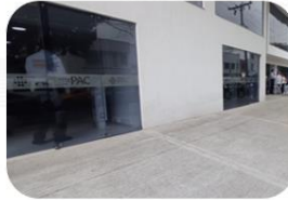
Rampa de acceso
