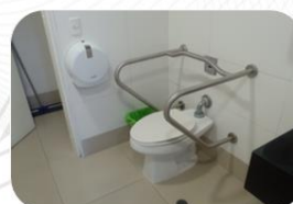
Baño con barandas soporte
