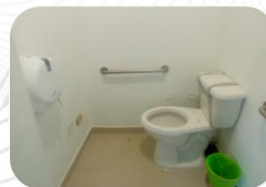
Baño con barandas soporte
