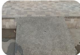
Rampa de acceso
