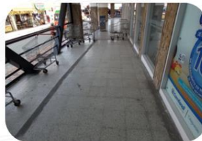
Rampa de acceso
