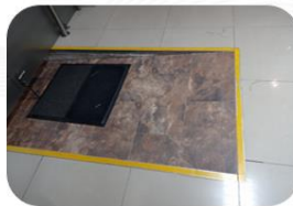
Rampa de acceso
