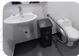
Baño con barandas soporte
