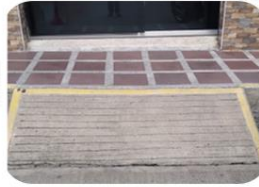
Rampa de acceso
