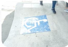
Rampa de acceso
