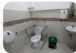
Baño con barandas soporte
