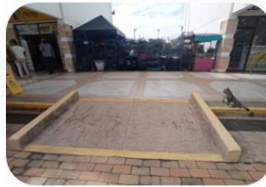
Rampa de acceso
