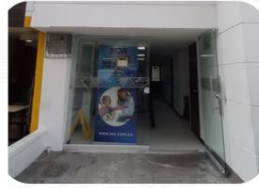
Rampa de acceso
