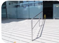
Rampa de acceso
