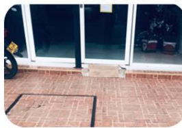
Rampa de acceso
