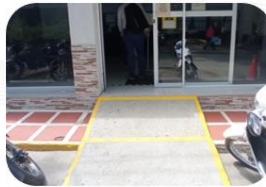
Rampa de acceso
