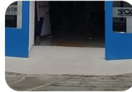
Rampa de acceso
