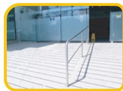
Rampa de acceso
