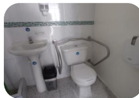
Baño con barandas soporte
