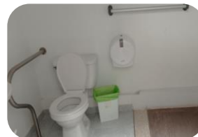
Baño con barandas soporte
