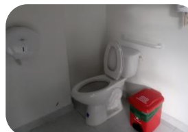
Baño con barandas soporte
