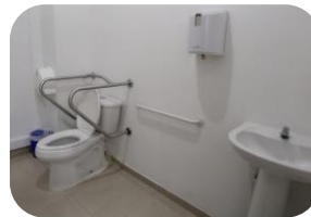
Baño con barandas soporte
