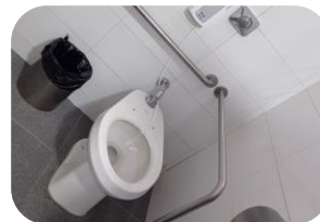
Baño con barandas soporte
