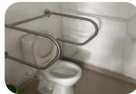
Baño con barandas soporte
