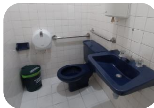
Baño con barandas soporte
