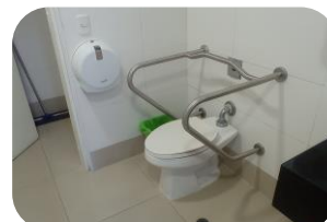
Baño con barandas soporte
