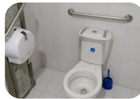
Baño con barandas soporte
