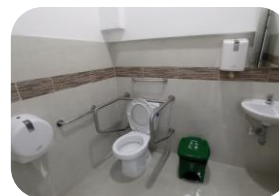
Baño con barandas soporte
