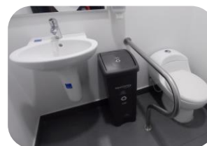
Baño con barandas soporte
