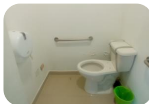
Baño con barandas soporte
